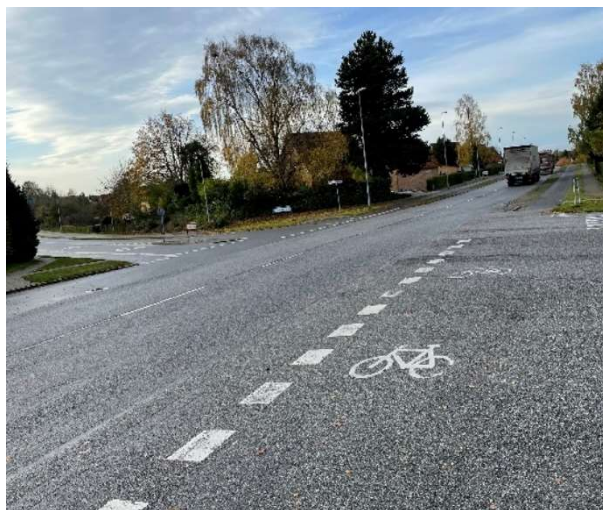
Figur 17 - Grønningen, skrå tilslutning af sidevej og skillerabat ført langt frem mod kryds.
